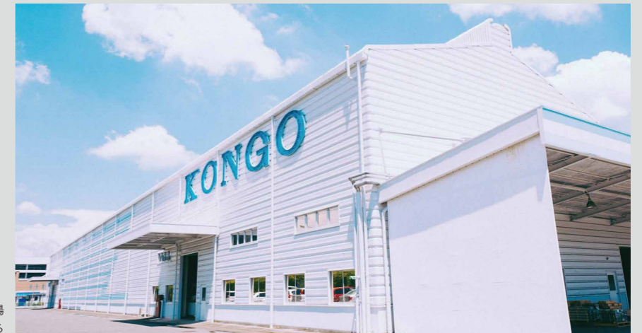
熊本市の旧工場 現在は解体作業が進んでいる
